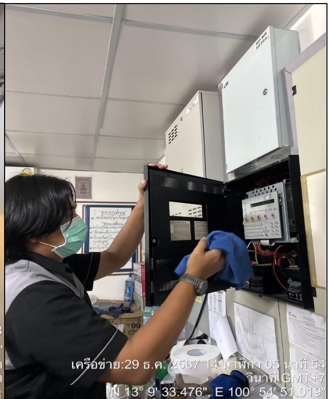
ภาคผนวกที่ 3.48 จัดให้มีการซ่อมบำรุงรักษาอุปกรณ์ ป้องกันและสัญญาณเตือนอัคคีภัย
